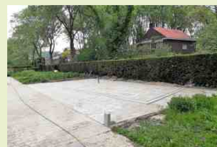
vloer en terras gelegd
